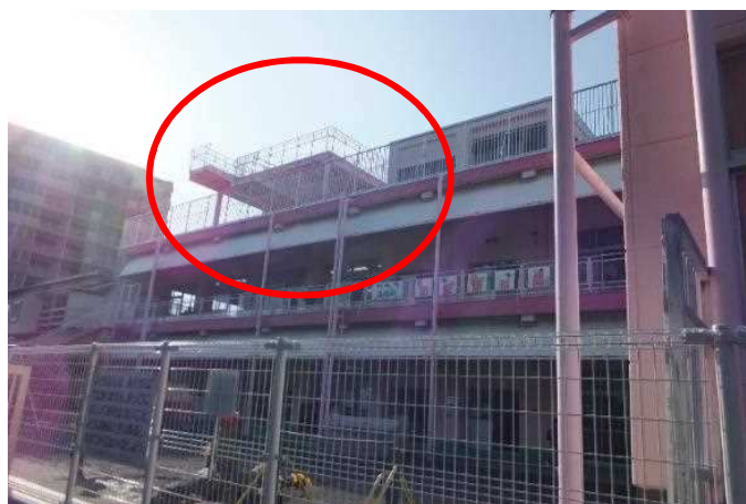
図 15 屋上への避難場所を増築した事例
