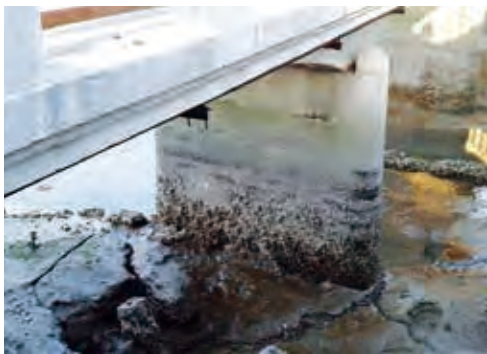
国見町神代橋
