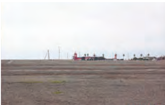
地方創生に国見町多比良港埋立地
