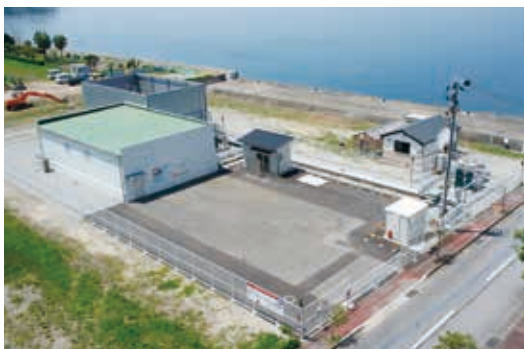
小浜温泉バイナリー発電所
