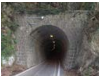
千々石第二トンネル
