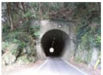
千々石第一トンネル
