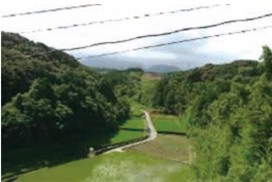
夏峰土石埋立処分場の遠景
