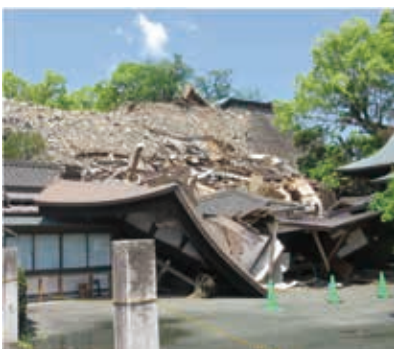
熊本地震による家屋の被害状況
