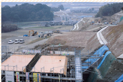
【地域高規格道路「島原道路」の様子（工事中）】
