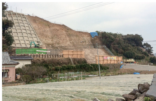
【急傾斜地崩壊対策工事の様子(中ノ場地区)】
