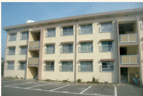
【市営玉垣住宅A棟の様子】
