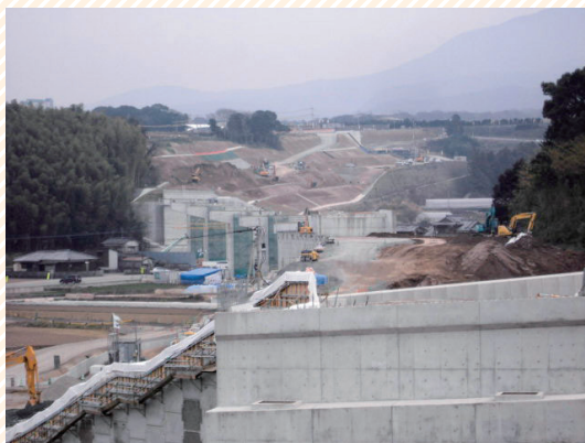
【地域高規格道路「島原道路」の様子(工事中)】
