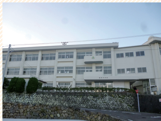
【南串中学校（外壁改修工事完了）】
