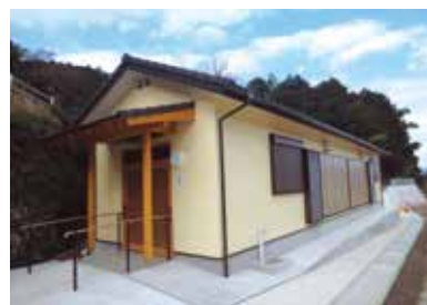
平木場自治会 平木場公民館の建設（吾妻町）
