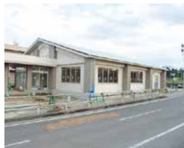
建設中の国見総合支所
