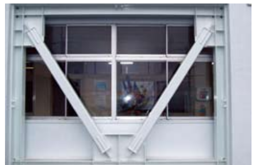
耐震補強工事が行われた校舎
