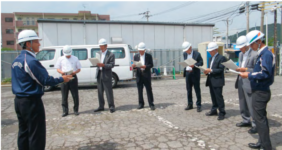
愛野コミュニティセンター(仮称)新築工事現地
