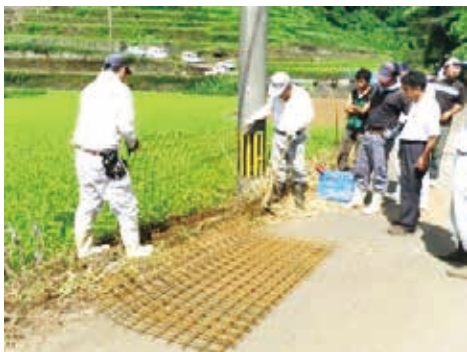
イノシシ対策研修（防護柵設置）
