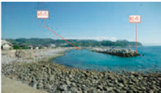
赤間漁港離岸堤
