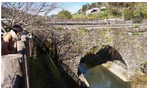
写真 南島原市北有馬町にある元平橋。大正10年に架けられたこの石橋は、玄武岩を組んでつくられています。
