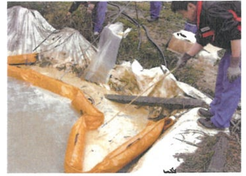
③. 重油の回収作業
