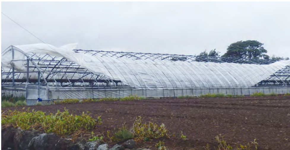
台風被害を受けた農業用ハウス
