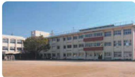
愛野小学校校舎
