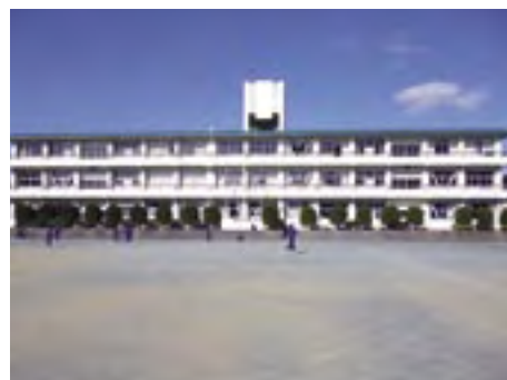
小浜中学校耐震補強事業
