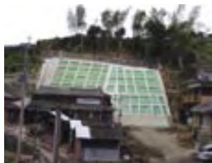
急傾斜地崩壊対策事業
