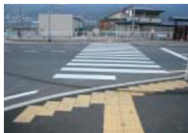
点字ブロックの設置
