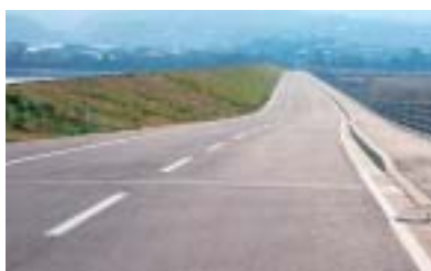
諫早湾潮受堤防道路
