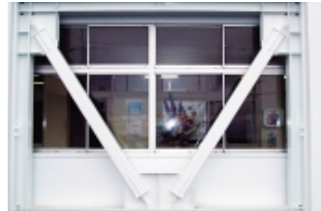
耐震補強工事が行われた校舎
