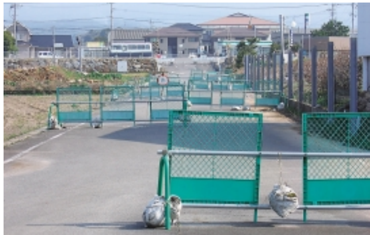
諫早湾干拓堤防工事用道路
