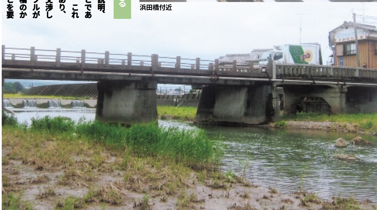
改修事業に入る予定の浜田橋
