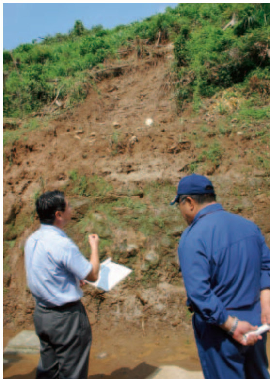
↓吾妻町の中阿母地区では、民家近くの山が崩れ、雨で押し流された土砂が民家に流入
