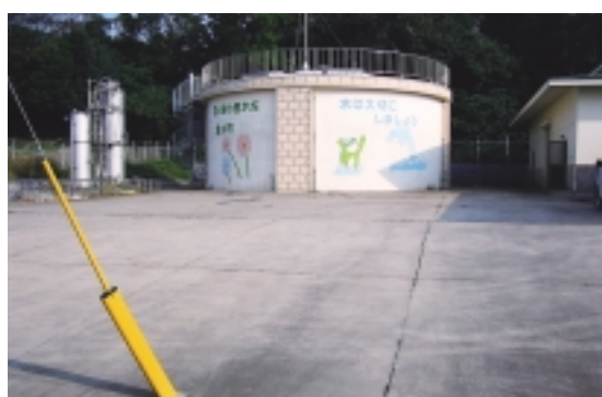
水道配水タンク等（愛野町）
