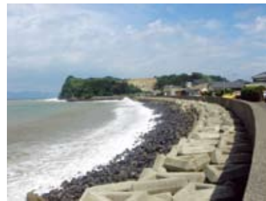
⑤塚ノ山自治会の海岸。消波効果なども計算して設置したブロックですが、台風時は、波が越える時があります。
