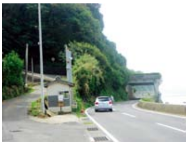
②国道251号に設置されている遮断機。県が管理し、谷間川と交差する市道との間に設置されています。
