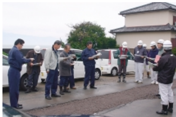
岡2工区下水道工事（瑞穂町）
