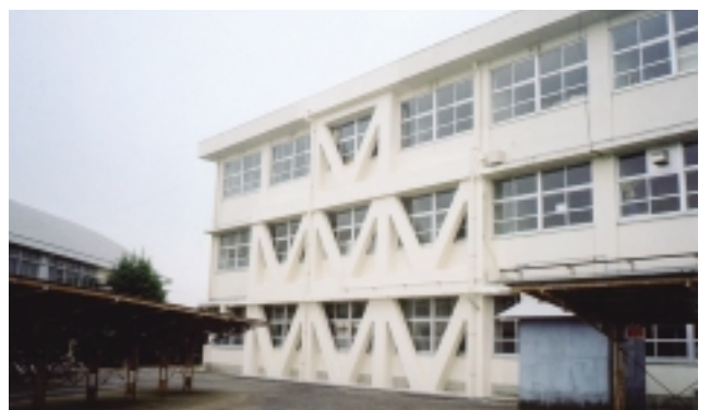
耐震補強工事を行った校舎
