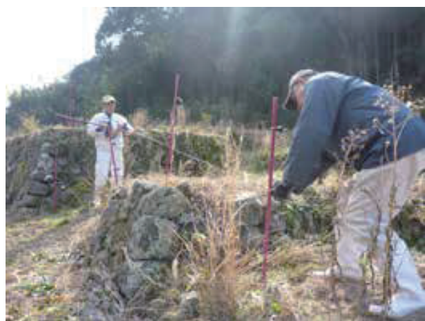
電気柵の設置作業
