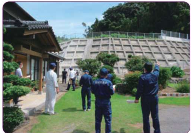
急傾斜地崩壊対策工事
