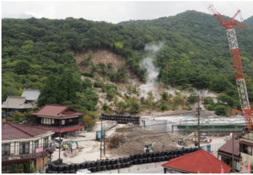
土砂崩れが発生した雲仙温泉街＝8月30日撮影
