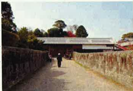
修理された旧鍋島家住宅長屋門
