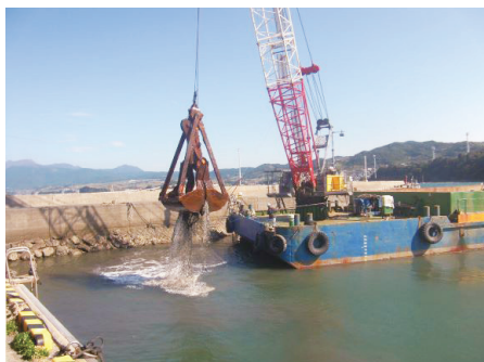
【漁港の浚渫作業の様子】
