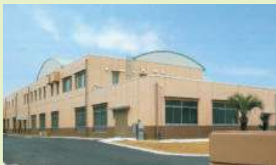
木質バイオマスボイラーの導入が進む市環境センター＝国見町
