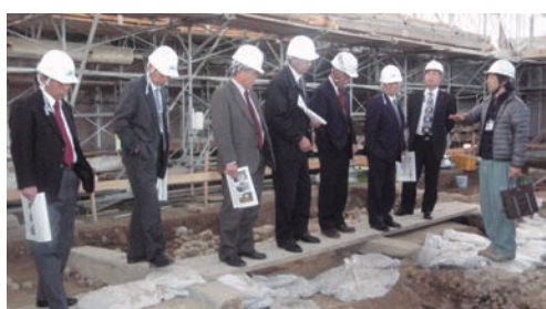
旧鍋島家修理工事現場
