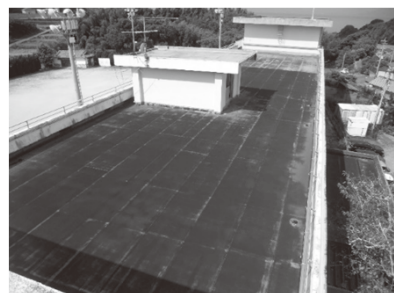
南串第一小学校校舎（屋上）
