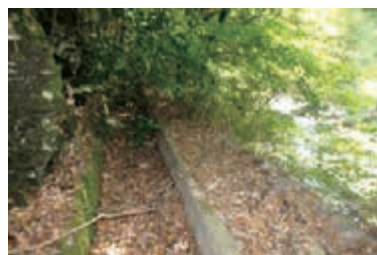
発電用に水を引くための導水路
