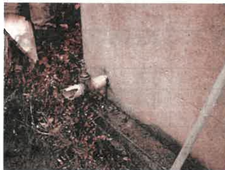
②. 防油堤のひび割れとバルブ
