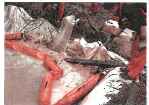
③. 重油の回収作業
