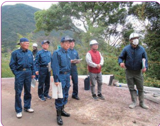
現地視察（市道木場山領線改良事業）
