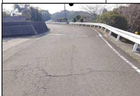
排水対策工事 起点側
