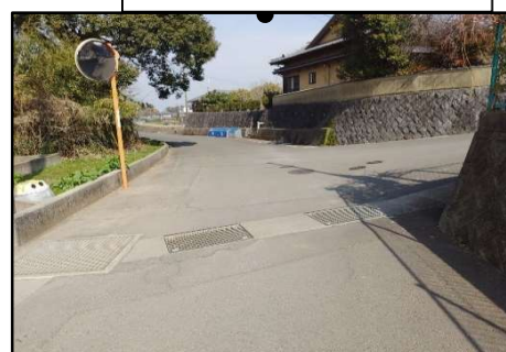
排水対策工事 終点側
