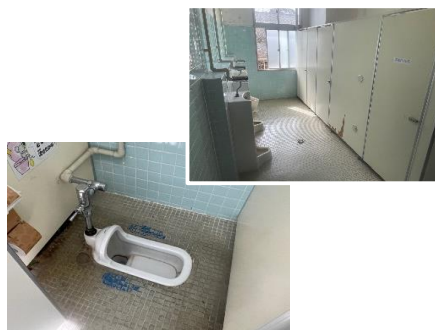
トイレ洋式便器取替工事
