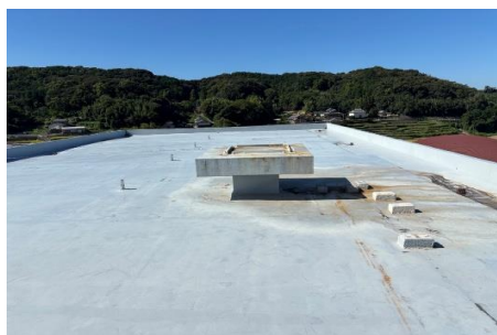
川床小学校校舎屋上防水等改修工事
