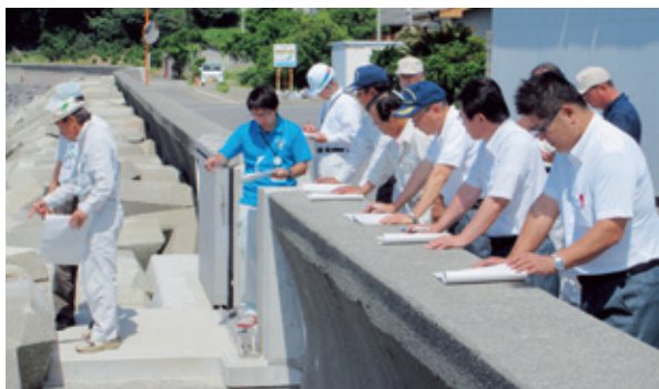
南申山赤間漁港海岸高潮対策工事
