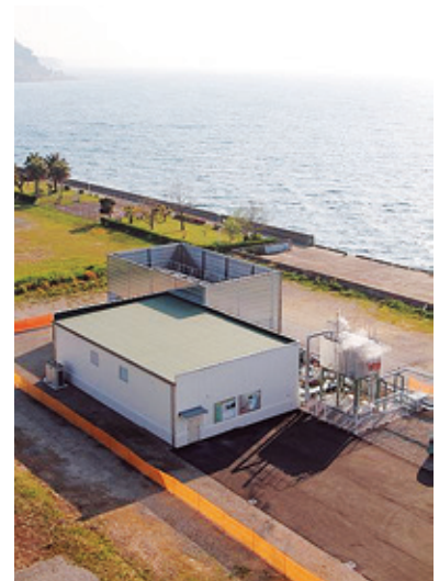
小浜バイナリー発電所
