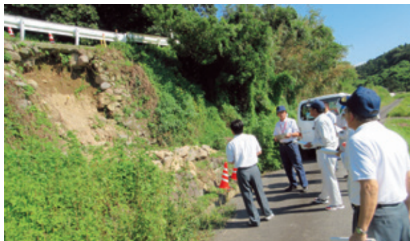
市道吾妻西光寺線道路災害復旧工事
