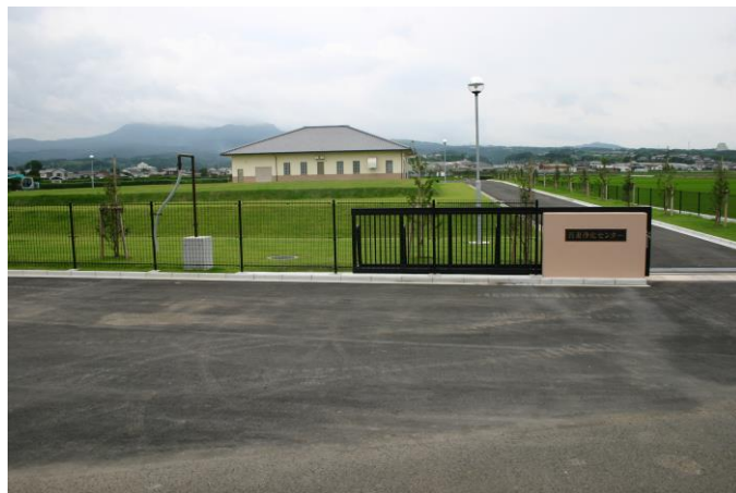
吾妻浄化センター
