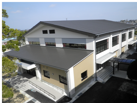
【神代小学校体育館（雨水活用施設）】
