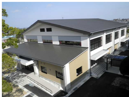
【神代小学校体育館（雨水活用施設）】
